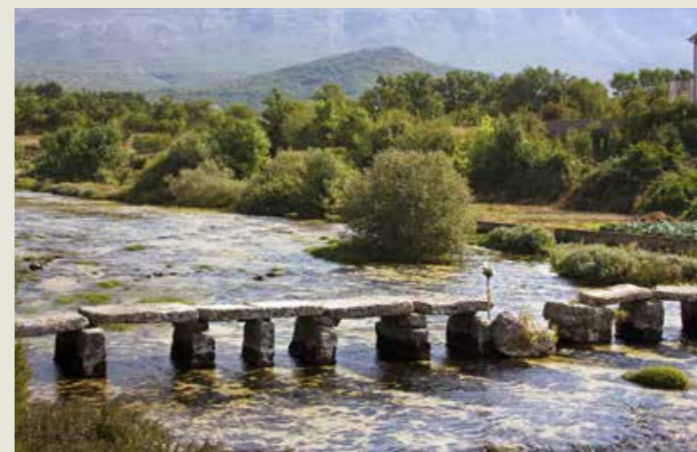
Slab bridge on the River Cetina built of stećak tombstones Pločasti most na rijeci Cetini izgrađen od stećaka
